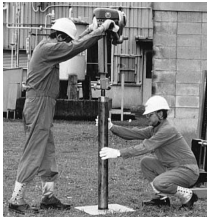
●機械簡易ボーリング (SCSC方式)
